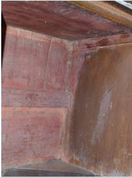
Abb.21: rote Erstfassung unter der Sitzbank
