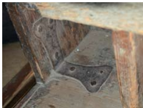
Abb.19: Befestigung der Brüstung mittels Eisenwinkel
