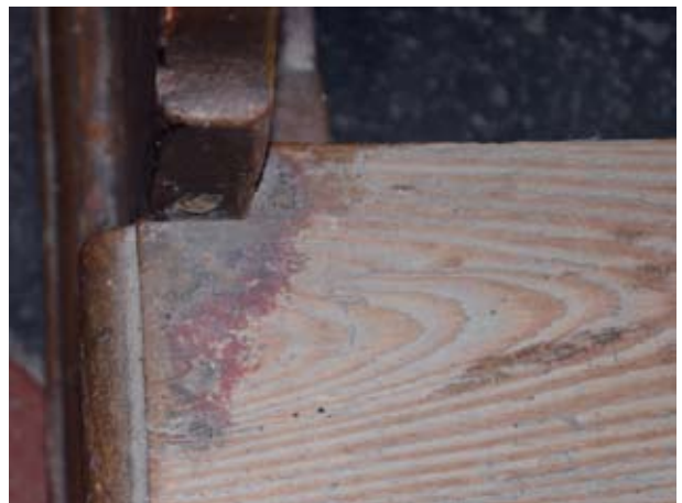
Abb.42: Reste beider Fassungen am Rand einer Kniebankoberseite
