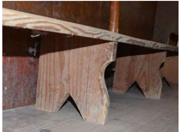
Abb.18: spätere Kniebank mit genagelten, geschweiften Stützen
