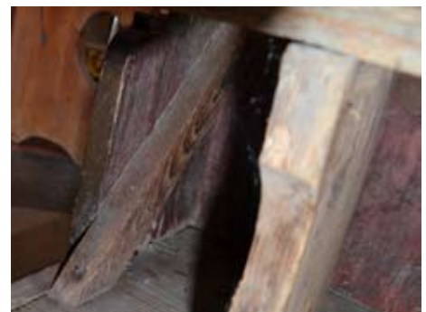
Abb.20: Befestigung durch diagonal eingestellte Leiste
