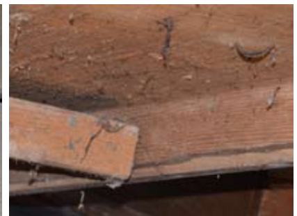
Abb.29: Veränderte Podesthöhe durch aufgesetzte Sockelleiste
