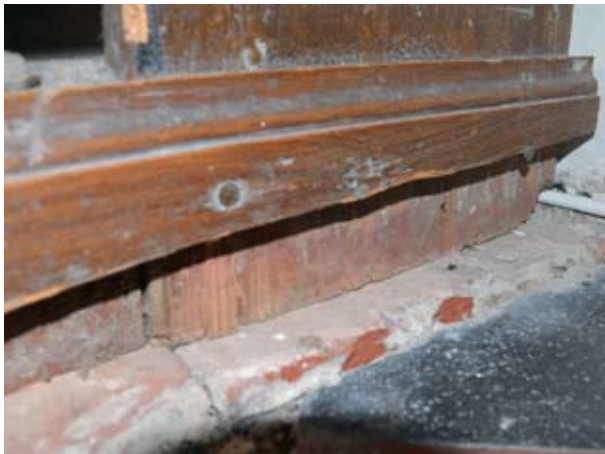
Abb.13: Eingelassene Wange mit gebrochener Sockelblende
