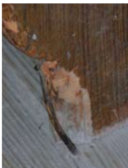
Abb.31: Abgesplitterte und mit Nagel fixierte Vorderkante einer Sitzbankstütze
