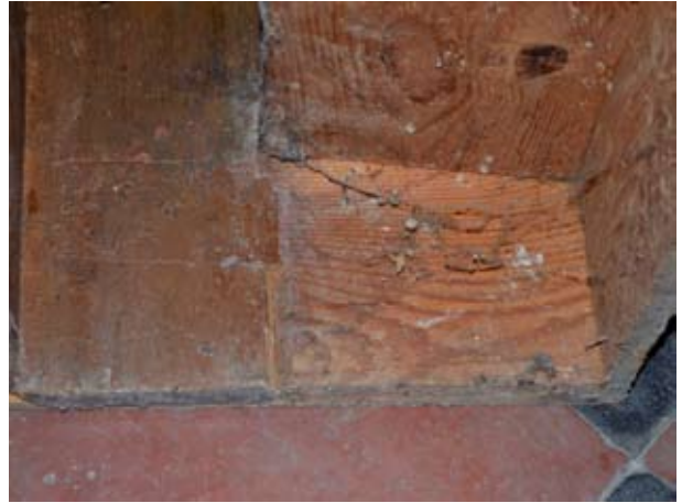
Abb.16: Innenseite mit eingeschobenem Zapfen
